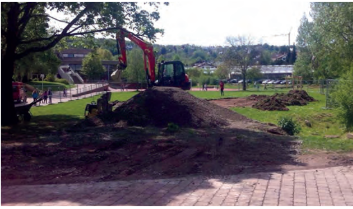
Baubeginn der Strecke
